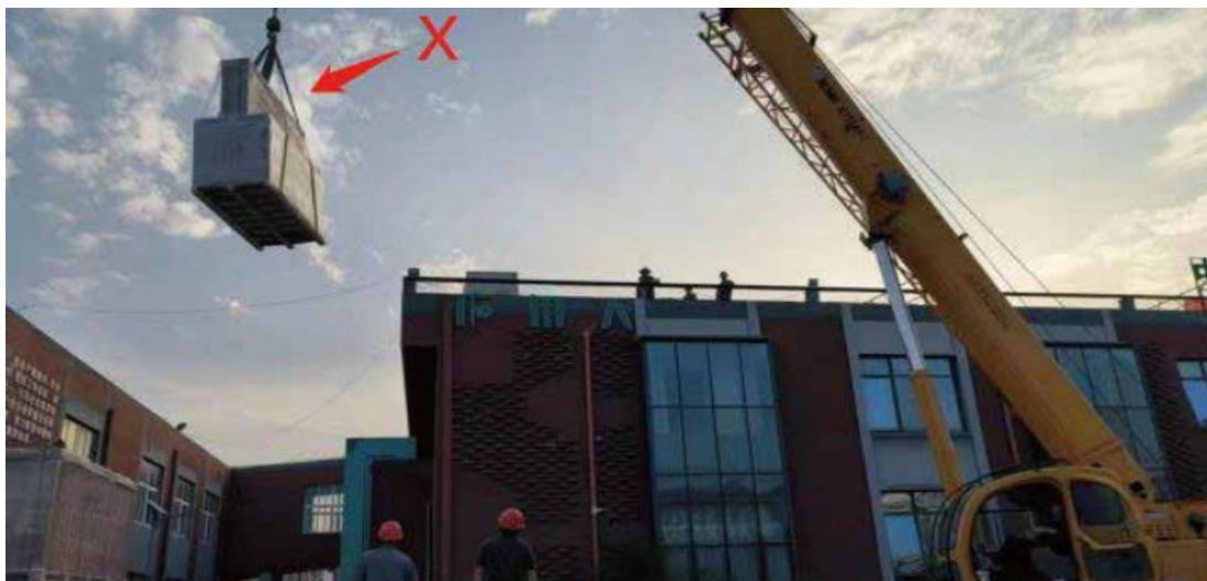
(Рисунок 10. Неправильна схема транспортування складених коробок краном)
